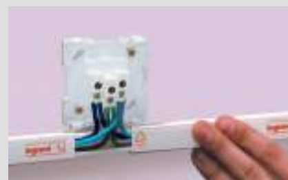
Cortar a tampa da canaleta tomando como referência a base do mecanismo e encaixá-la.
