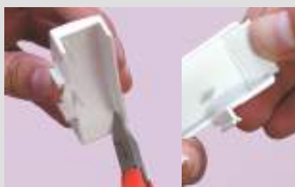
Remover o pré-corte do acoplador
