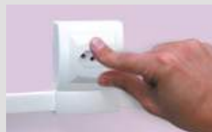
Encaixar a tampa à base do mecanismo e retirar a película protetora.
