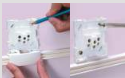
Posicioná-lo na canaleta para marcação do furo. Furar e fixar o mecanismo sem o acoplador.
